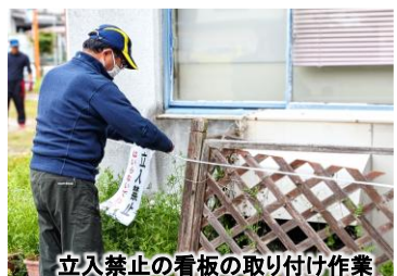
立入禁止の看板の取り付け作業
